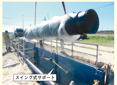
石川県羽咋市 送水管敷設現場
