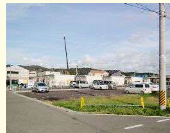
仮設住宅(写真手前)の奥では 新築住宅の建設が進む
