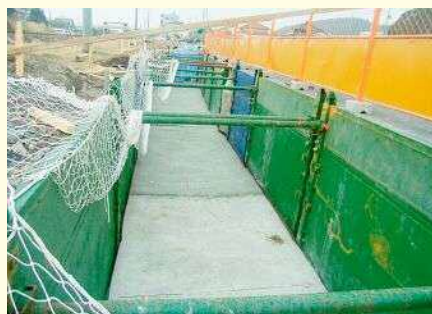
BOX カルバート設置前
