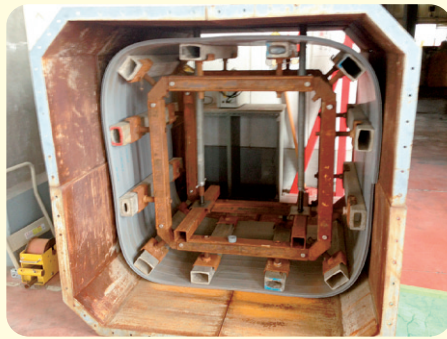
SPR (製管) 工法
