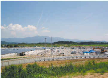
ソーラーパネル設置現場
