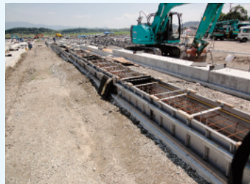
基礎施工状況
