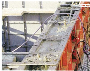
天端ターゲットを使用して生コンを打設している様子 愛知県東浦町：K組さん現場
