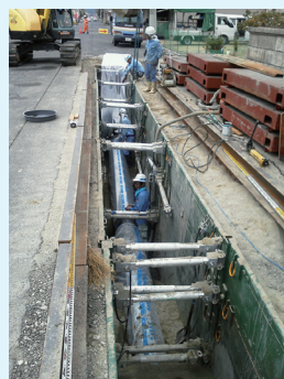
送水管敷設:広島県福山市
