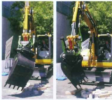
7トンクラスの掘削機に取付け(X12)
