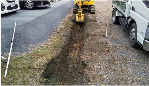
①所定の深さまで掘削を行います
