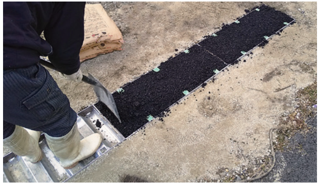
④上蓋に舗装を行い設置完了です
