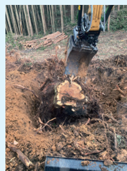
切株の周囲を掘削
