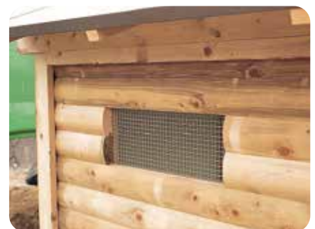
両側に通風窓が開いています。
