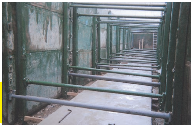
■ボックスカルバート用レール施工例
