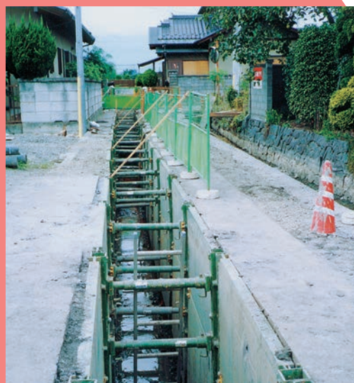
■クイック土留レール式施工例
