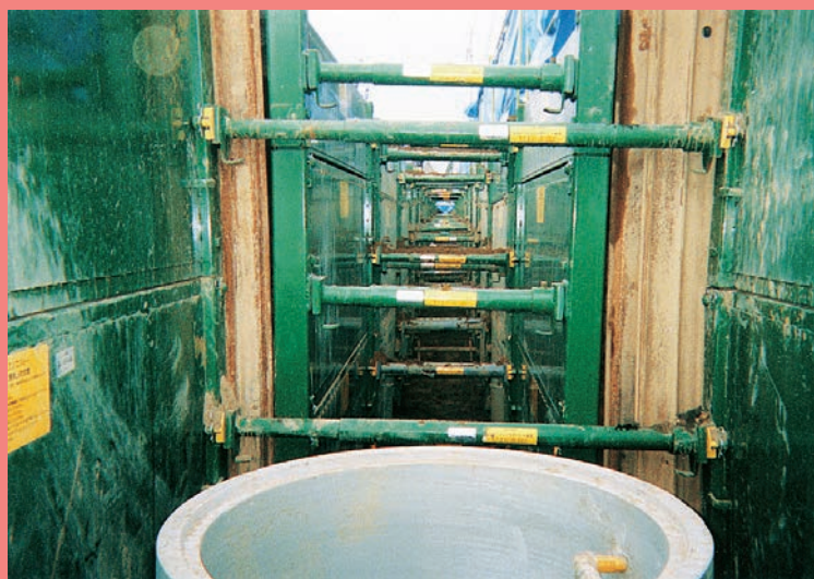
■クイック土留レール式施工例
