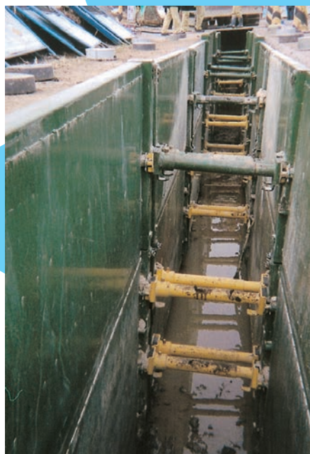
■粘性土用サポート施工例
