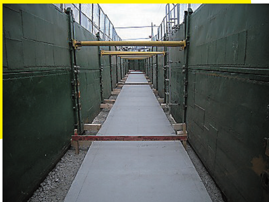
■縦梁連結金具施工例
