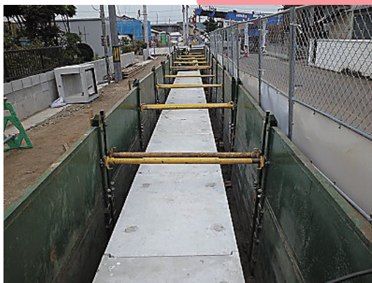
■縦梁連結金具施工例
