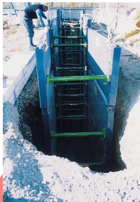
■深掘パネル施工例
