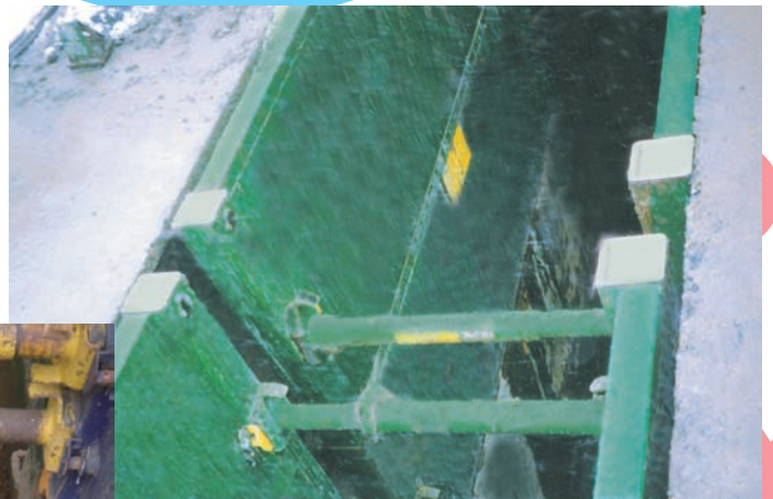
■縦梁キャップ施工例
