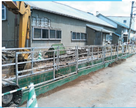
■クイックフェンス施工例(BOX式)
